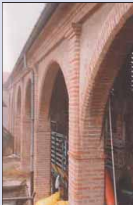
Particolare dei portici
