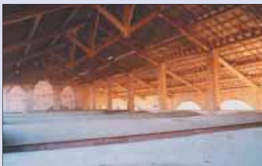
Particolare del tetto
